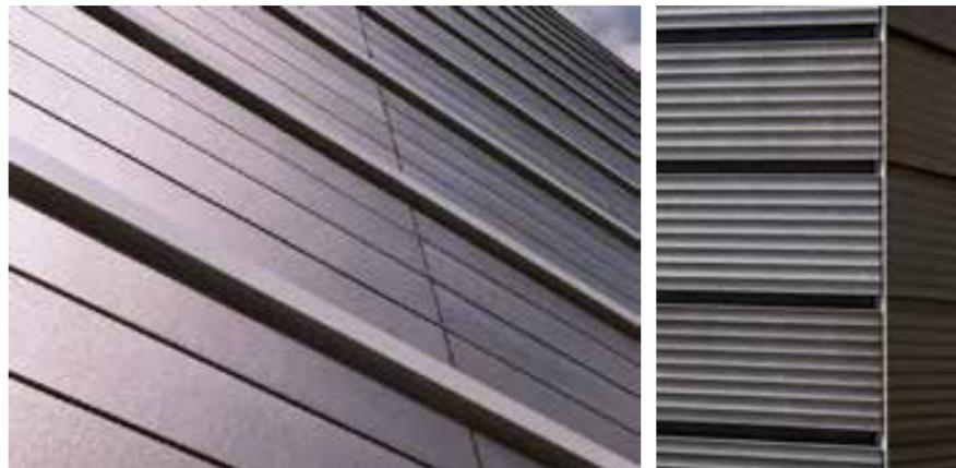
Mit dem gleichmäßigen Aufbringen einer Engobe erhalten unsere Elemente einen ganz neuen, farbigen Charakter. Von der Anlage her umfassen die Engoben ein Farbspektrum, das auf zarte Farben abgestellt ist und ganz spezielle Wirkungen in Richtung Pastellfarben zulässt. Hierdurch lassen sich bestimmte dekorative Konzepte umsetzen, die den Vorstellungen des kreativen Architekten entspricht.
