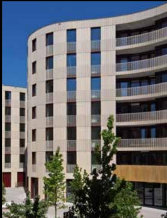
Die vertikale Montage großformatiger Fassadenplatten gewinnt zunehmend an Bedeutung. Immer mehr Architekten planen und gestalten ihre Fassaden mit einem vertikal orientierten Fugenbild. NBK hat hierfür eine spezielle Unterkonstruktion entwickelt, welche eine zwängungsfreie Montage der Platten in vertikaler Ausrichtung ermöglicht. Ebenso wie bei der Horizontalmontage sind auch hier die Platten zwischen den Profilen frei spannbar und benötigen keine Mittelunterstützung.
